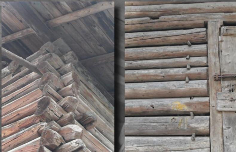
Pagina a fronte, immagine grande: l'incastro d'angolo degli stelàri innestato sul montante della porta; nelle immagini piccole: altro particolare dell'incastro d'angolo e dettaglio con i sórdi di rinforzo della struttura.
