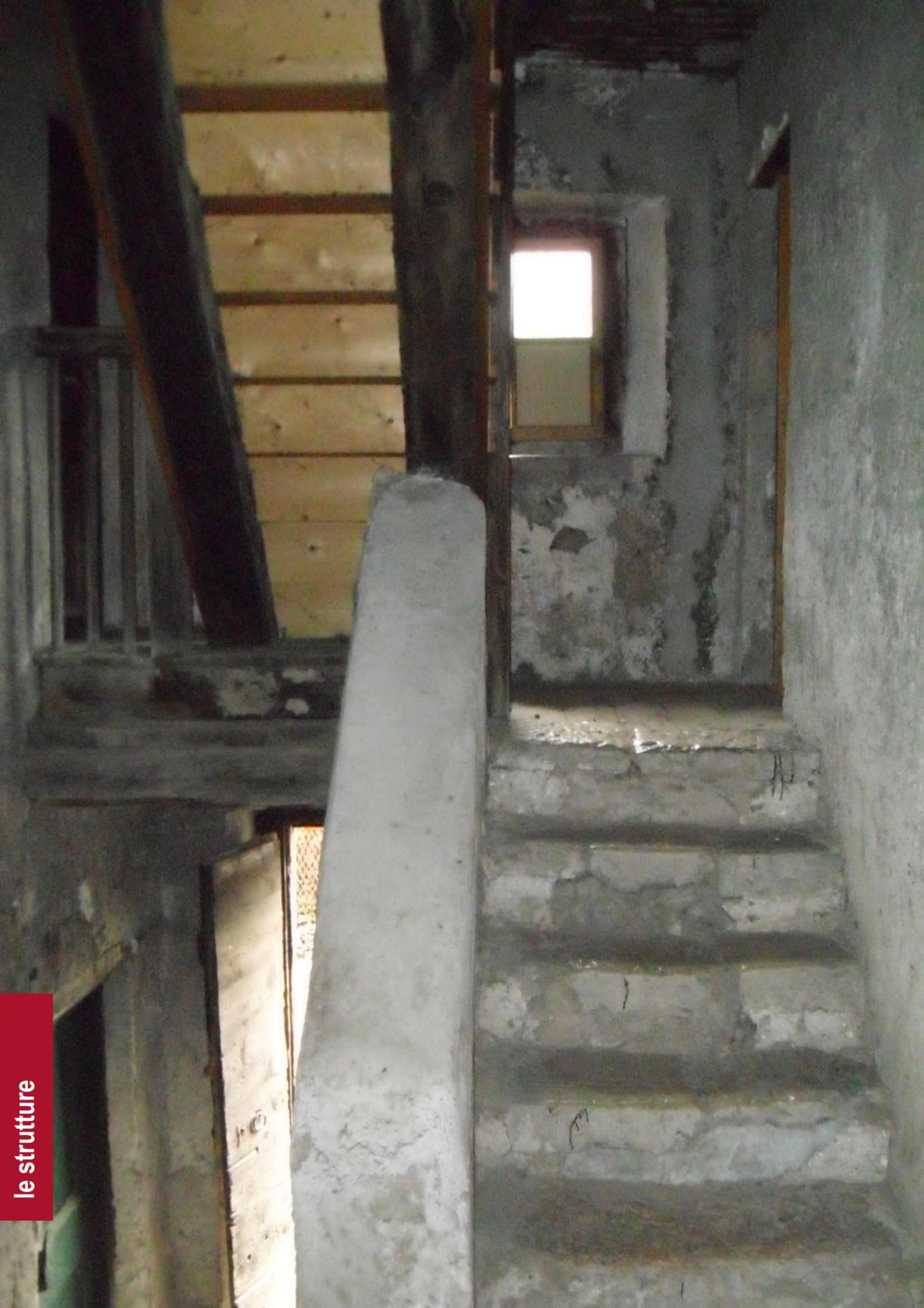
*Pagina a fronte: scala con la prima rampa ed il parapetto in muratura e la seconda rampa in legno.
